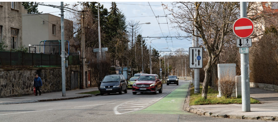
Obr.7 ▲ Vďaka širšej ulici sa na cykloobojsemku zместil aj protismerný cyklopruh. 📍 Ulica Prokopa Velkého, Bratislava.
