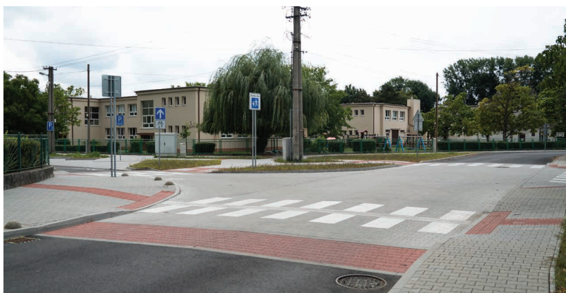
Obr.9 ▲ Vyvýšená križovatka na ulici pri škole. 📍 Školská ulica, Zohor.
