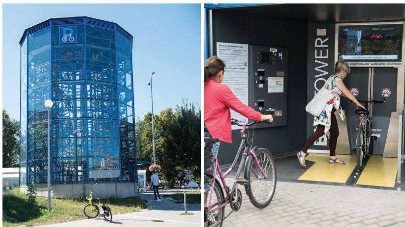
Obr.28 ▲ Výhodou cykloveže je vysoká bezpečnosť uschovaných bicyklov. Nevýhodou je jej vysoká obstarávacía cena a dlhá doba čakania na obsluhu, pokiaľ príde viac ľudí naraz (cca 30 sekúnd na jedného). 📍 Železničná a autobusová stanica, Trnava.
