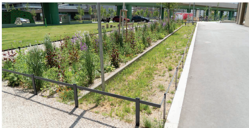
Obr.17 ▲ Vyspádovanie dažďovej vody z chodníka do záhonu. 📍 Am-Ostrom-Park, Seestadt, Viedeň.
