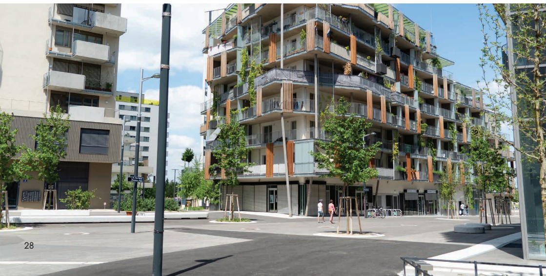
Obr.37 ▼ Komunikačný uzol vo vnútri štvrte, tiež bez áut. 📍 Anna-Bastel-Gasse, Seestadt, Viedeň.
