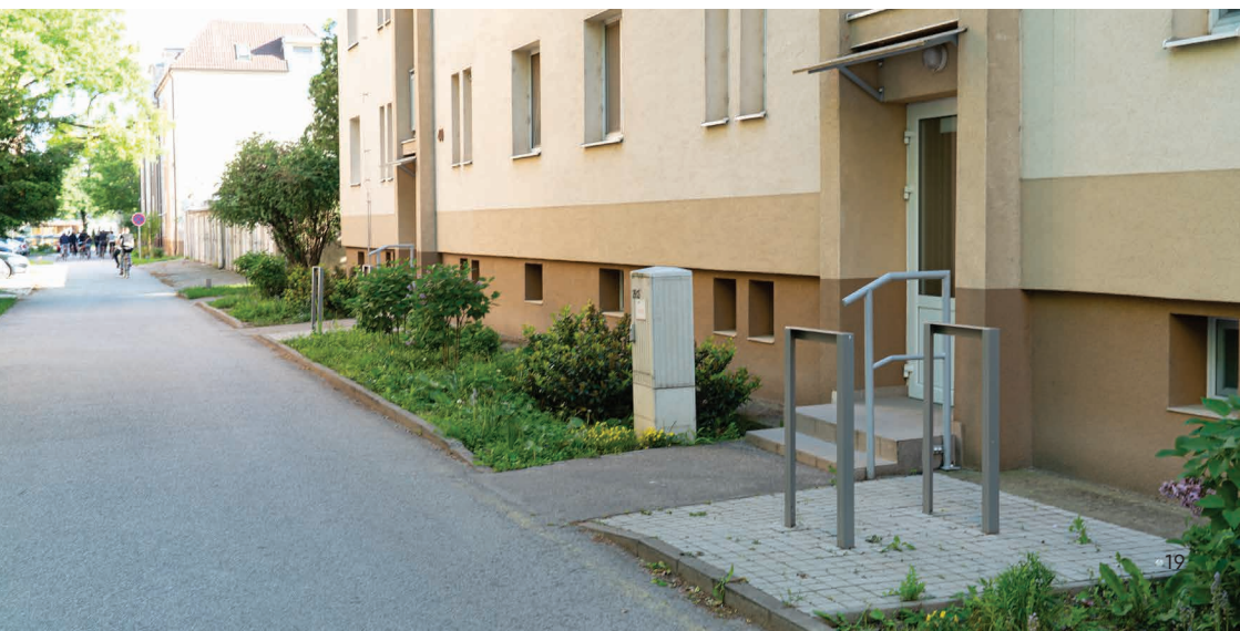
Obr.22 ▼ Stojany pre návštevy pred vstupom do bytového domu. 📍 Trnava.
